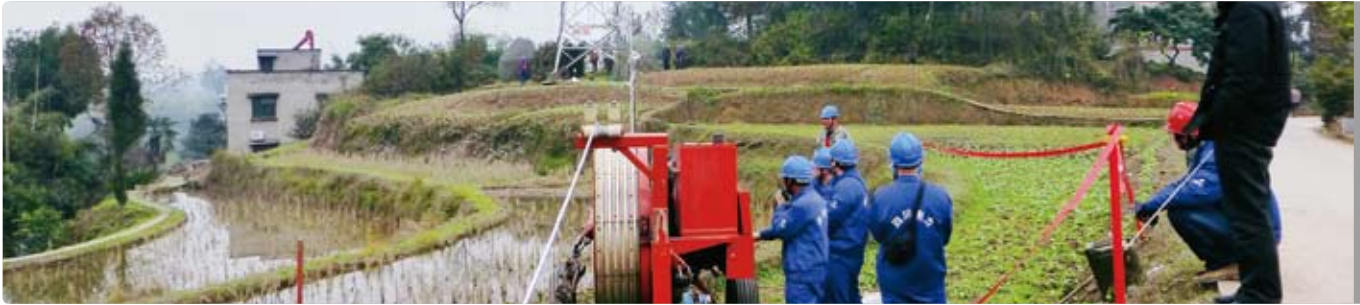
四川林洞线施工
