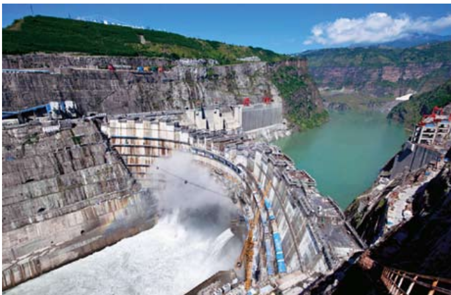
高性能低热硅酸盐水泥成功应用于当今世界装机最大的拱坝——溪洛渡水电工程
